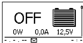
Abb. 4: Display nach dem Einschalten der externen Batteriesicherung
