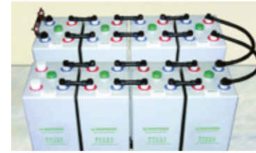
Abb. 5-15: Einsatz von Reihenverbindern und Stufenverbindern
