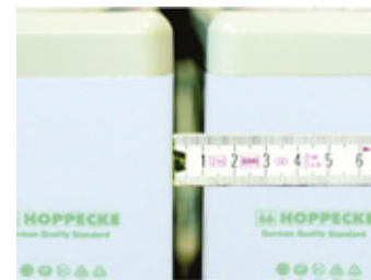
Abb. 5-14: 10 mm Abstand zwischen den Batteriezellen
